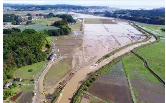
飯崎地区(南相馬市小高区) 東日本大震災と原発事故後、営農再開を目指し、ほ場整備を実施中であつたが、小高川の堤防決壊により、ほ場に土砂が流入。
