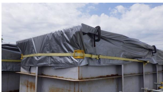
(写真3-2) 既設多核種除去設備周辺ノッチ タンクの養生状況①
