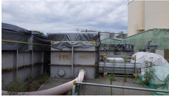
(写真 3 - 3) 既設多核種除去設備周辺ノッチ タンクの養生状況②
