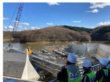
施工状況見学
