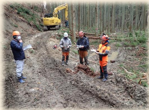
（いわき市三和町合戸地内）
