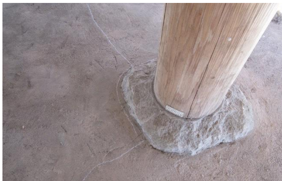
中心付近礎石周りの微細亀裂
