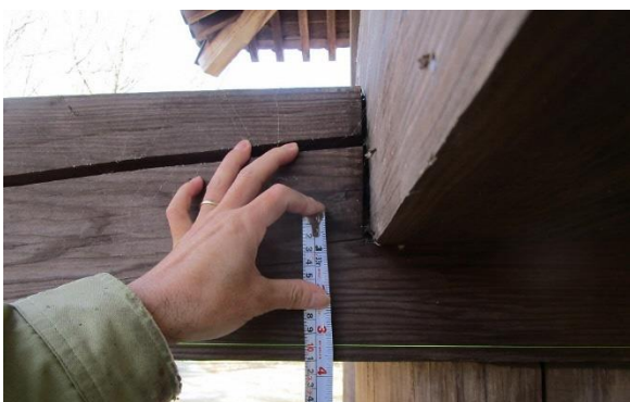
中心部分と西中央梁材の高低差（10mm）
