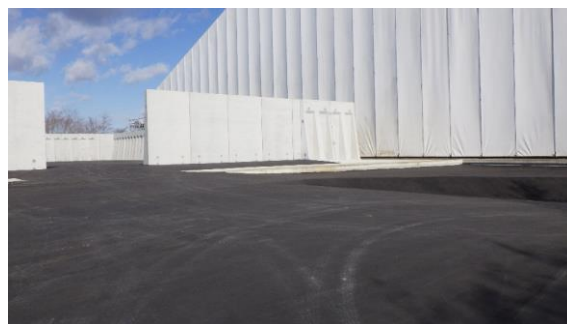
(写真 2-2) プレハブ小屋が撤去された様子 (今回撮影)
