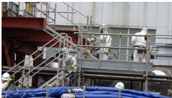
(写真1-2) 構台設置作業の状況 (西側から撮影)
