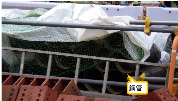
(写真 2 - 2) 鋼管設置のための資機材の状況②
