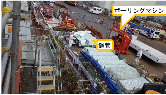
(写真 2 - 1) 鋼管設置のための資機材の状況①
