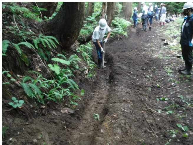
▲雨や山水でみちがぬかるんだり、洗掘されないための土側溝整備。
