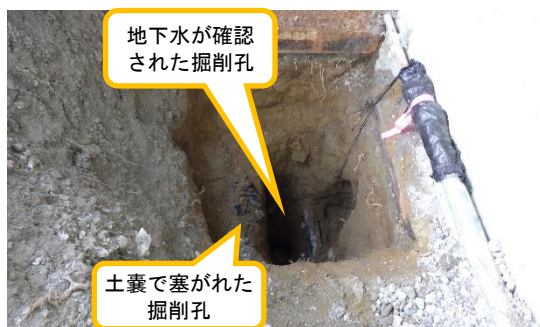
(写真2-1) 掘削箇所③の状況① (西側から撮影)
