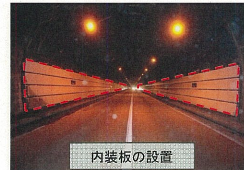
国道118号「下郷トンネル」(下郷町)
