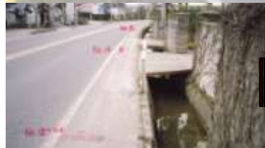
国道 121号(喜多方市)
