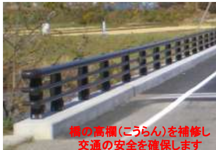
<橋りょう補修の整備例(国道115号)>
