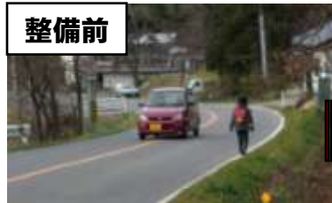
県道 小野郡山線(郡山市)
