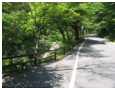
<県道 小野四倉線 防護柵の設置>
