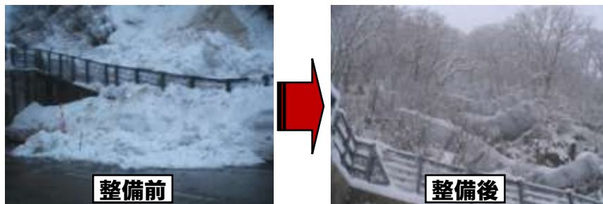
<喜多方市熱塩の雪崩を防止する整備事例(国道121号)>
