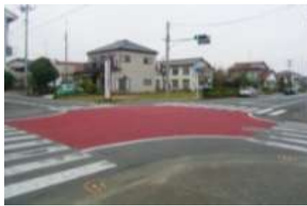
<県道 原町海老相馬線 交差点のカラー舗装>
