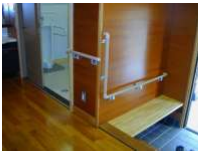
<手摺り設置で使いやすくなった集会所>
