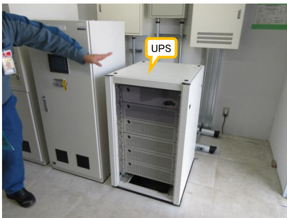
(写真2-2) モニタリングポストNo. 7のUPS
