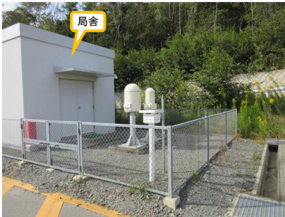
(写真1-1) モニタリングポストNo. 7外観
