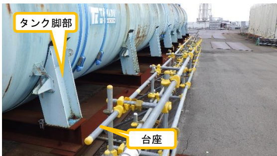
(写真1-2) 台座への固定状況
