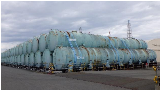
(写真1-1) ブルータンクエリアCの外観 (南西側から撮影)
