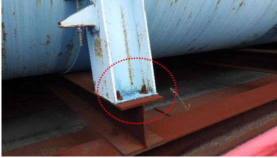
(写真1-3) ボルトによる脚部と台座の締結状況
