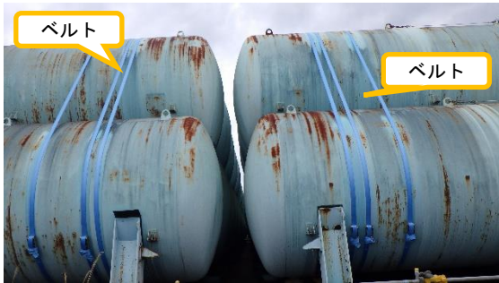
(写真1-4) ベルトによる固縛の状況①
