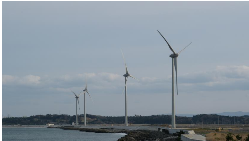
◆万葉の里風力発電所（南相馬市）（提供: (株)南相馬サステナジー）
