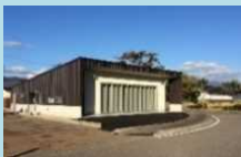
猪苗代水環境センター (猪苗代町)
