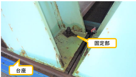
(写真1-2) ボルトによる台座への固定状況
