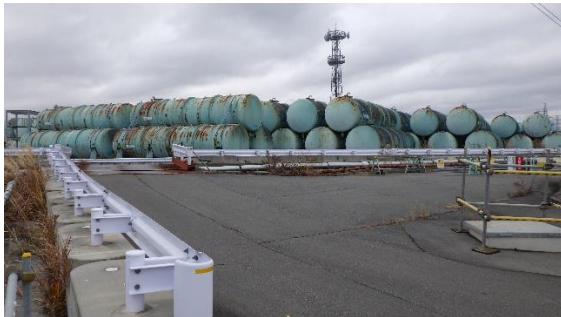
(写真1-1) ブルータンクエリアBの外観 (北東側から撮影)
