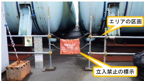
(写真2-1) 単管パイプによる当該エリアの区画 (南側入口)
