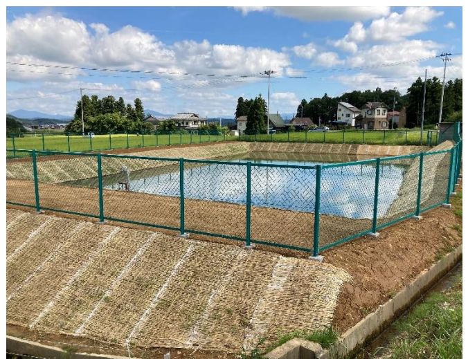
完成した牛子沢池
