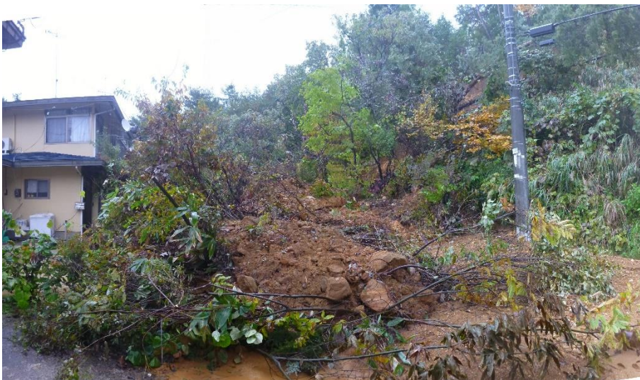
災害発生箇所(令和元年台風19号)
