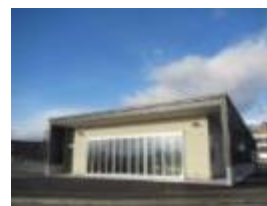
猪苗代水環境センター
