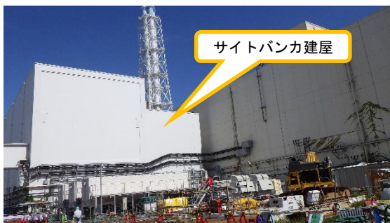
(写真4) サイトバンカ建屋の外観 (令和3年9月30日撮影)
