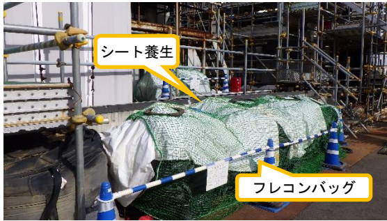
(写真 2 - 2) 被覆材の仮置き状況 (シート等で養生されていた。)
