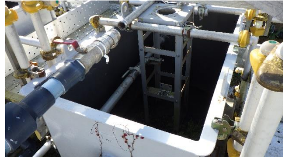
(写真 2 - 2) 撤去後の状況 (令和 3 年 11 月 17 日 撮影)
