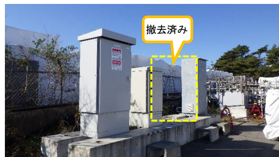
(写真 2 - 4) 撤去後の状況 (令和 3 年 11 月 17 日 撮影)
