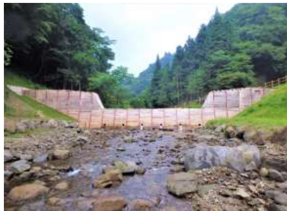
水源森林再生対策事業による治山施設の整備
