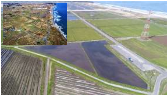
ほ場整備原町東地区(南相馬市)※左上:被災前の状況
