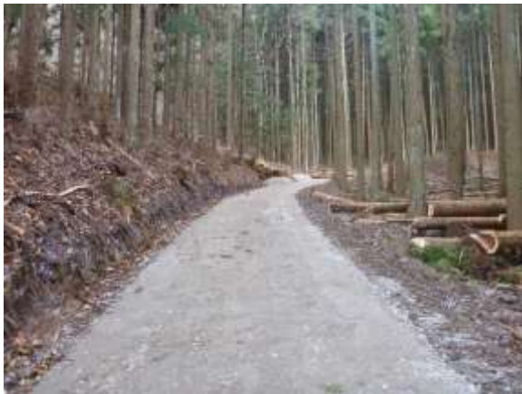
森林作業道の開設
