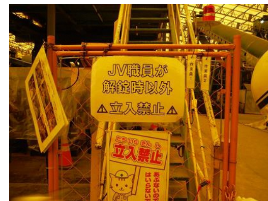
ガードフェンスの立入禁止措置
