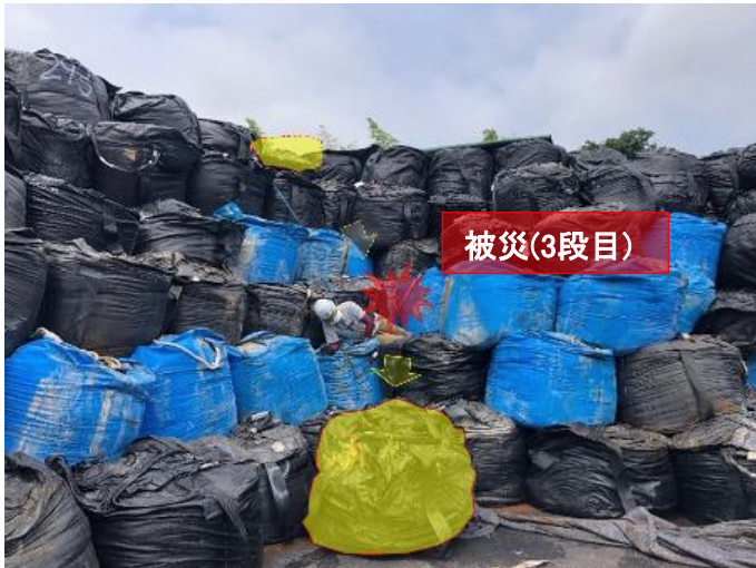
事故の発生状況（イメージ・黄色が大型土のう落下状況）
