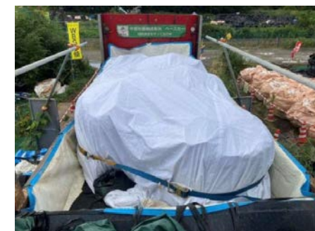
防水養生シートの固縛
