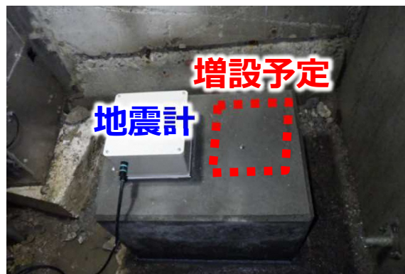
① 1階レベル (北西側構台下)
