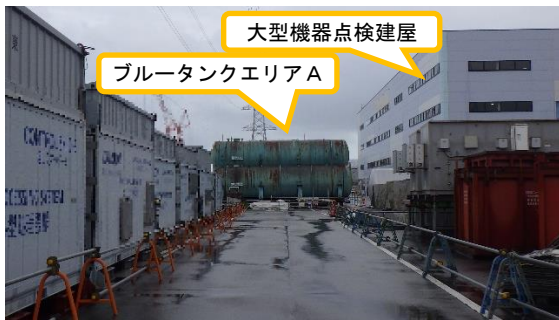
(写真1-1) ブルータンクエリアAの外観 (西側から撮影)
