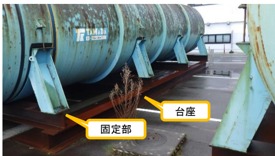
(写真1-3) ボルトによる台座への固定状況
