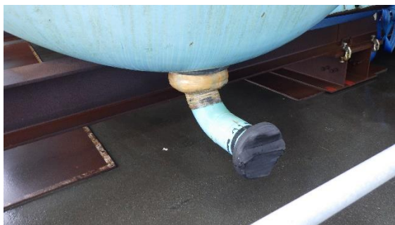
(写真3) 閉止フランジ部の状況
