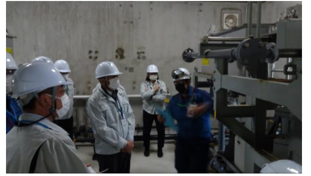
放水口モニタの調査の状況
