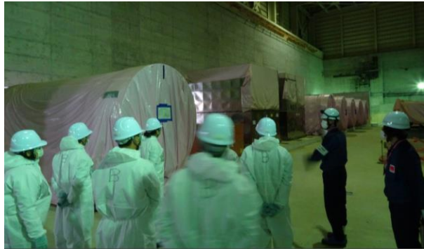
キャスク保管建屋での調査の状況
