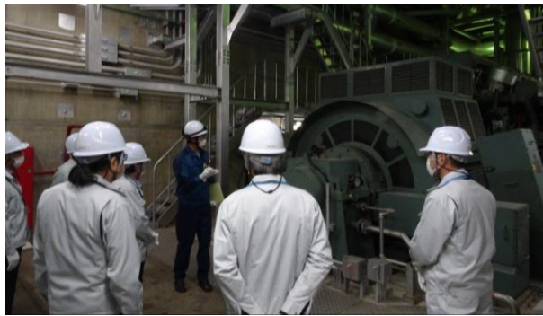
非常用発電機の調査の状況
