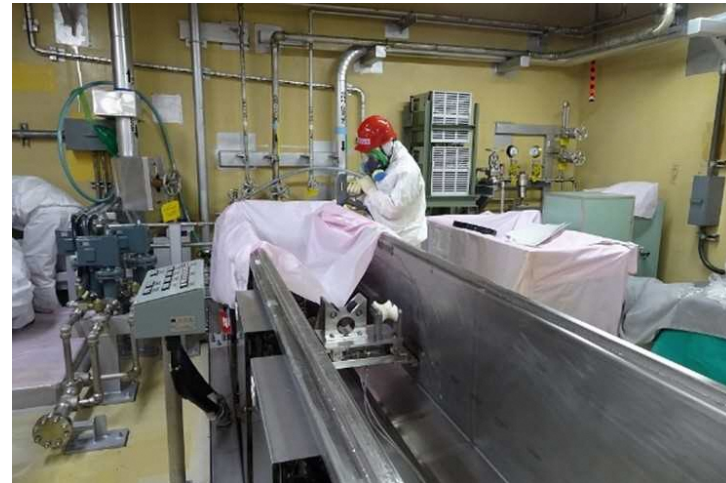
汚染の除去作業状況（3号機 制御棒駆動機構補修室）
