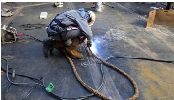
(写真 3) タンク底板の溶接作業
