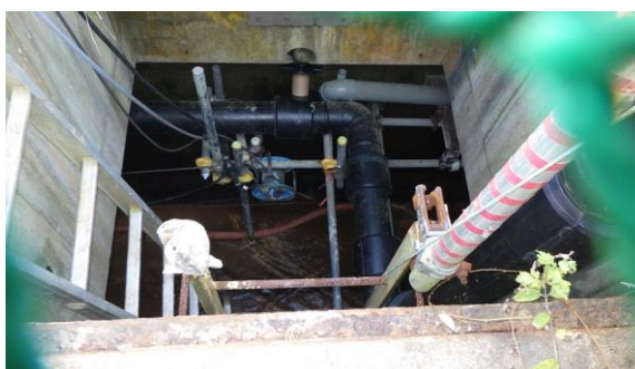
（写真6） K排水路立坑の状況
