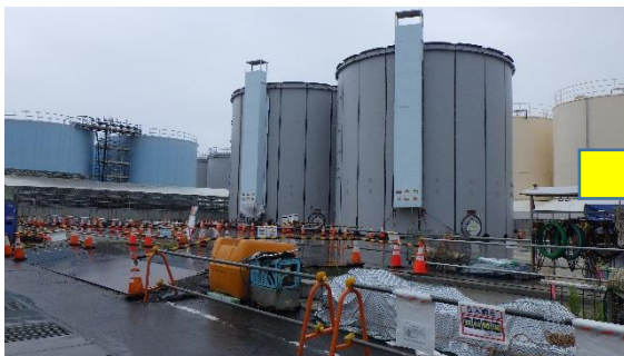
(写真1-1) G4北タンクエリアの状況 (前回(9月1日)南西側から撮影)
