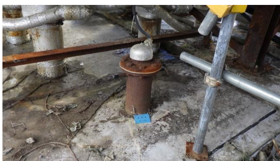
（写真4） 測温管頂部（150-7S）の状況
