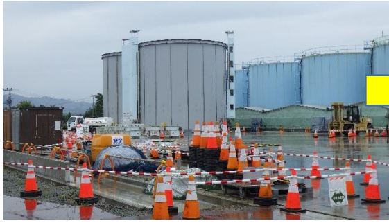
(写真 2-1) G 5 タンクエリアの状況 (前回(9月1日)南東側から撮影)
