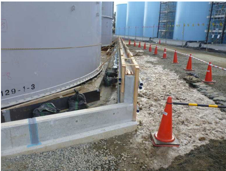
○現地確認 (G4タンクエリア) 堰の高さを75cmに嵩上げしている箇所
