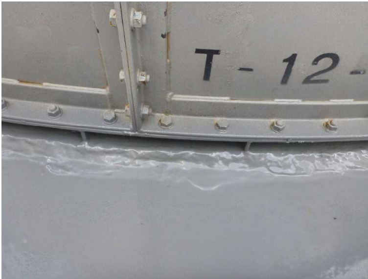
○現地確認 (G4タンクエリア) タンク底部の塗装施工状況の確認
