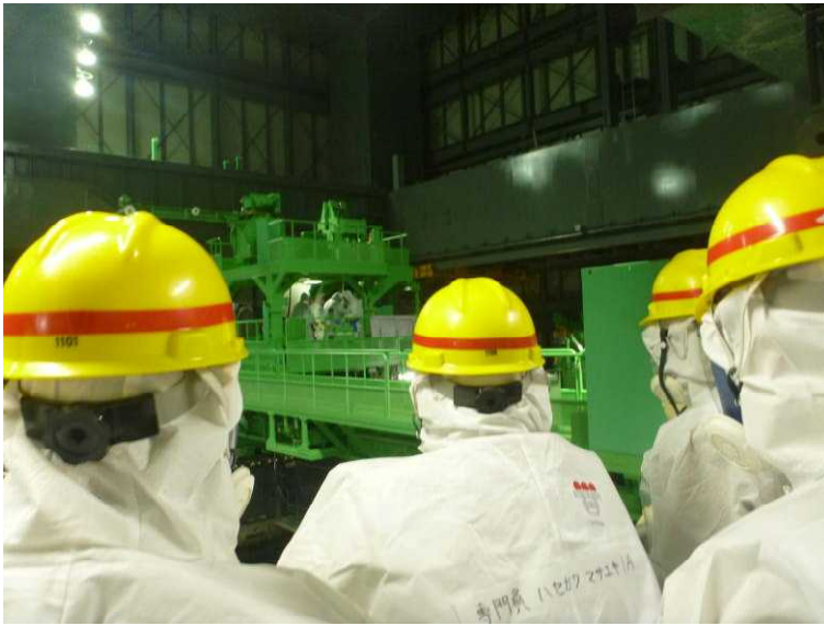
○現地確認 (4号機 燃料取替機)
