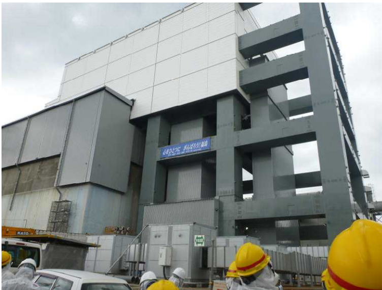
○現地確認 (4号機 原子炉建屋)
