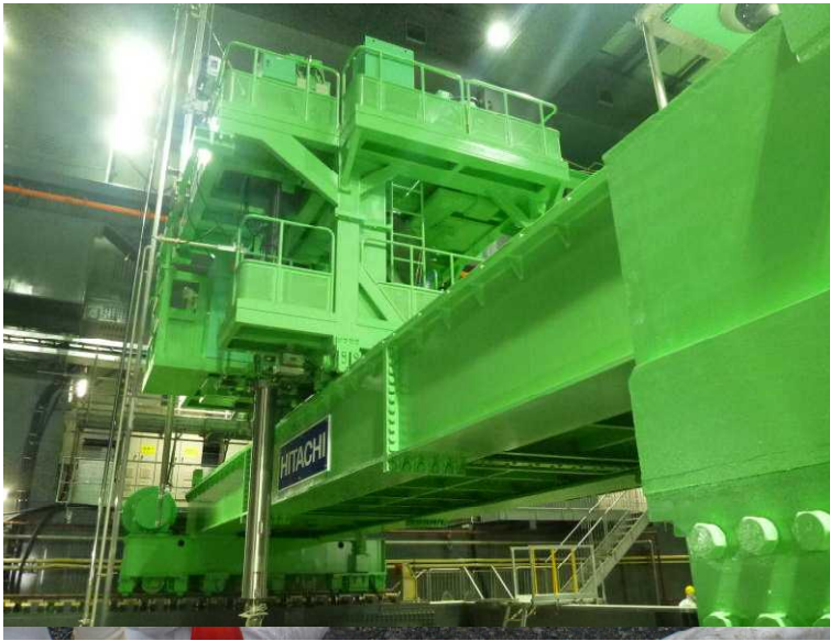
○現地確認 (4号機 燃料取替器)
