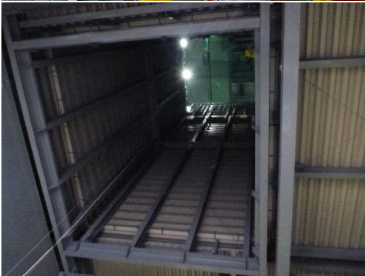
○現場確認 (4号機キャスク搬出用ハッチ)
