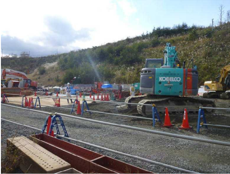
○凍土式遮水壁 実証試験 (共用プール建屋西側)
