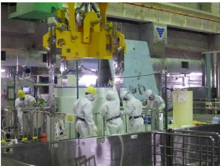
○共用プール建屋 キャスク搬出作業
