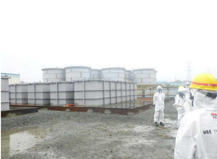
○現地確認 (4000 m 3 ノッチタンク)
