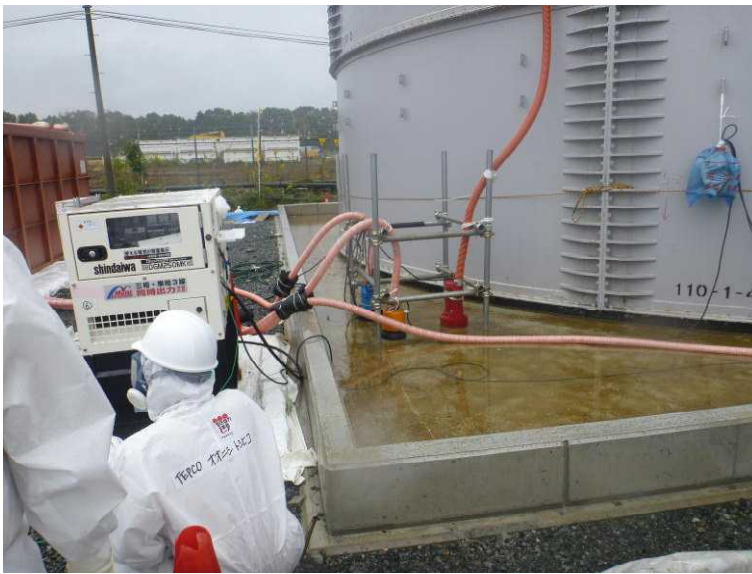
○現地確認 (Cエリアタンク)
