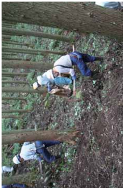
図-2-32：森林の除染（落葉の除去）の例
