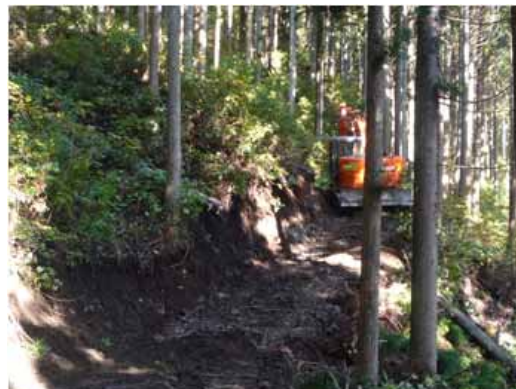
間伐材搬出支援事業による作業路整備の様子
