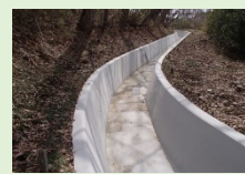
水路の長寿命化
