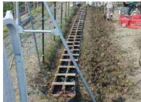
H 1 8 試験状況(施工後)
