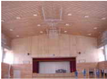
公共施設の内装木質化（会津坂下町）
