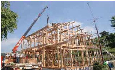
県産材を使用した住宅の建設
