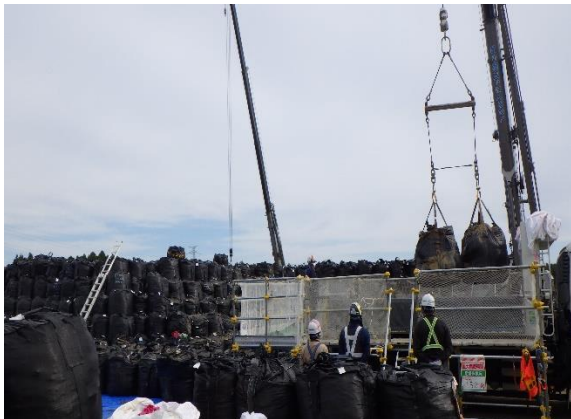
除去土壌等の積込作業
