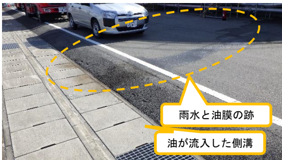
(写真1-1) G3西タンクエリア北側の 油漏えい箇所周囲の状況
