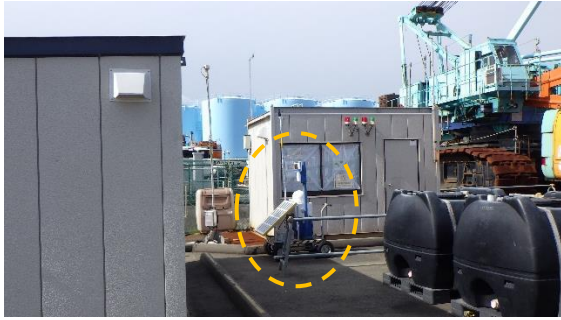
(写真3-1) 4号機南側法面に設置されている 線量表示器の状況
