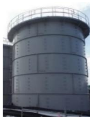
フランジ型タンク
