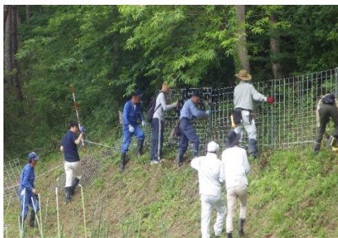
イノシシ被害防護柵設置の様子 (川内村) (施策④)
