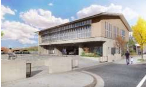
改築工事で ZEB 化を実現した須賀川土木事務所
