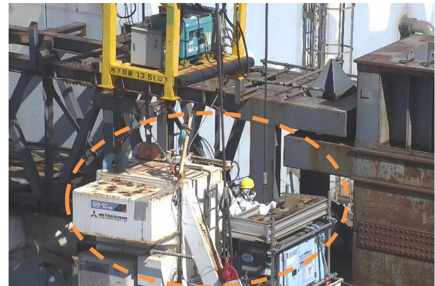
<吊作業デッキ>
