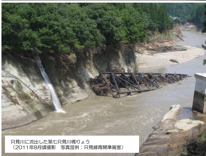
只見川に流出した第六只見川橋りょう (2011年8月頃撮影 写真提供：只見線再開準備室)
