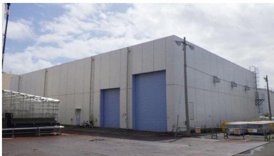
(写真1) サブドレン他浄化装置建屋の状況
