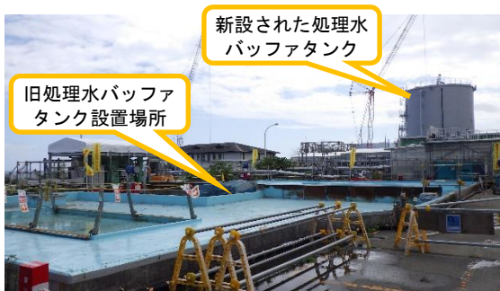
(写真 3) 旧処理水バッファタンク設置場所付近の状況
