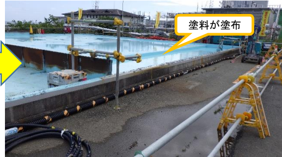
(写真4-2) 撤去後の状況 (令和3年9月16日撮影)
