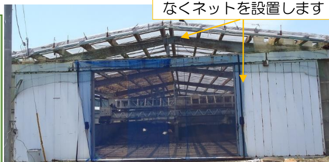
堆肥舎への防鳥ネット設置の一例
