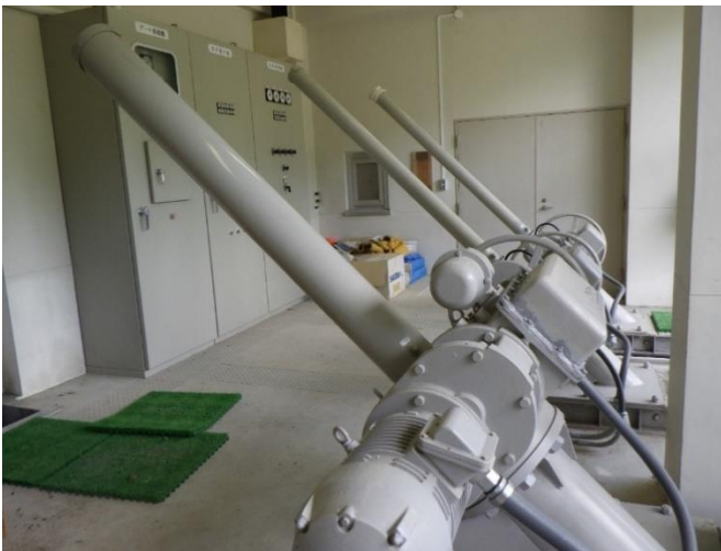
大笹生ダムゲート操作室の点検(福島市)
