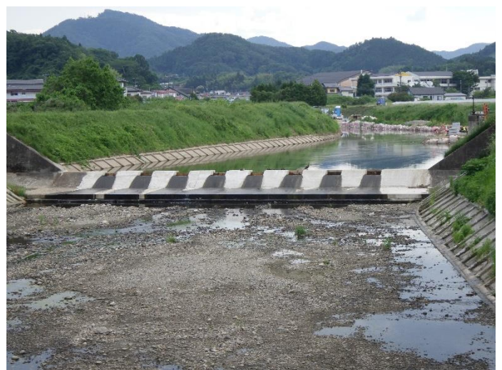
復旧工事後の状況(令和3年5月)
