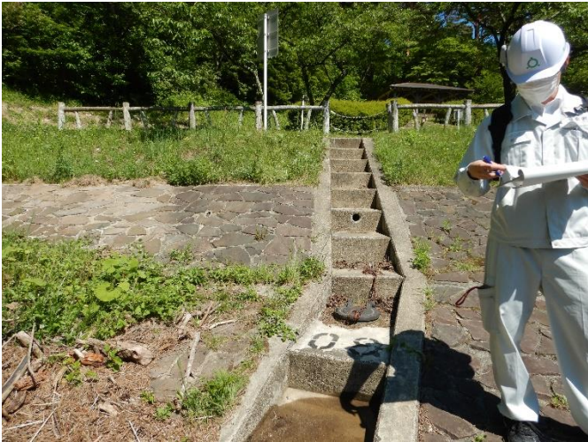
半田沼取水施設の点検(桑折町)
