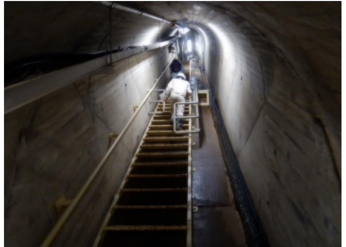
岳ダム監査廊内の点検(二本松市)
