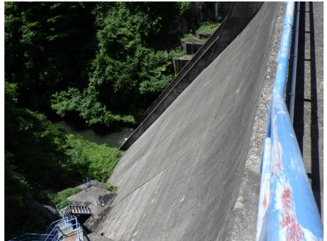
藤倉ダム堤体の点検(桑折町)
