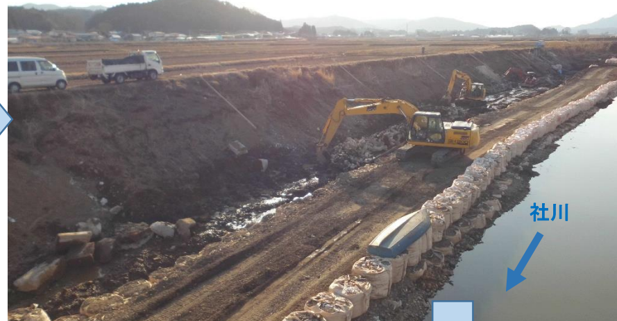
【施工状況（令和3年7月9日撮影）】
