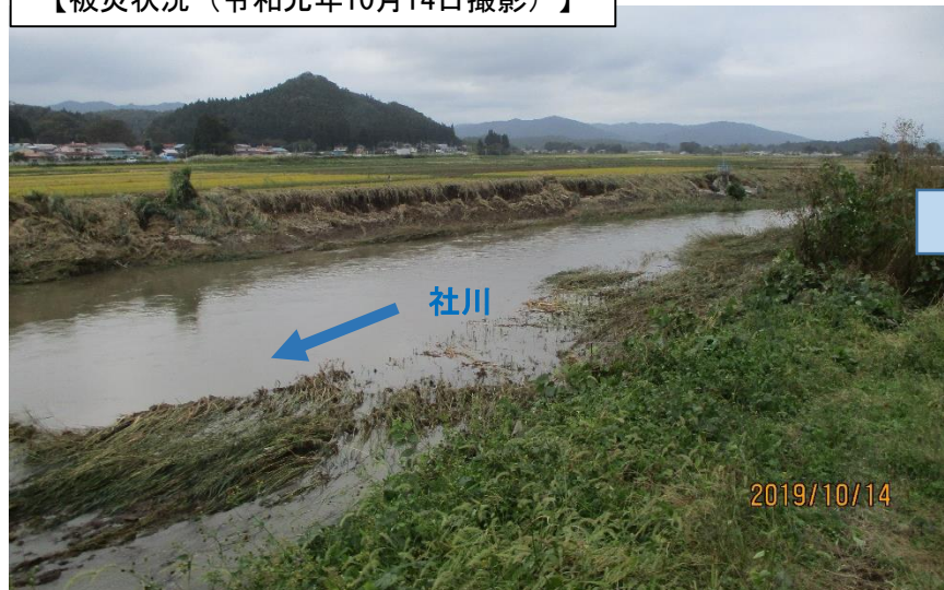
【被災状況（令和元年10月14日撮影）】
