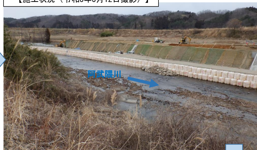
【施工状況（令和3年3月12日撮影）】
