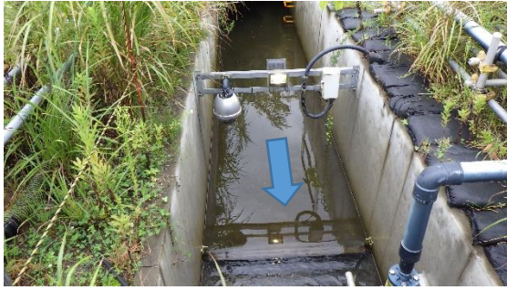
(写真1-1) 物揚場排水路の状況① (下流(東側)から撮影)
