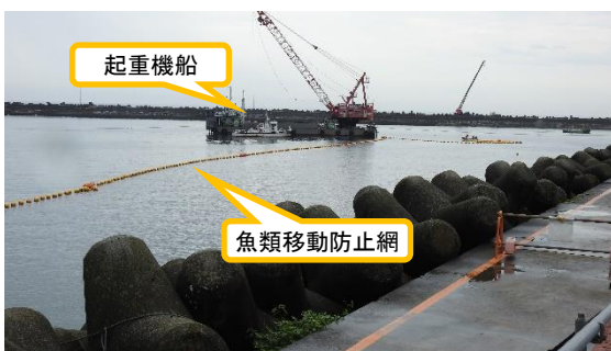
(写真2-1) 魚類移動防止網の設置状況① (東波除提北側から撮影)
