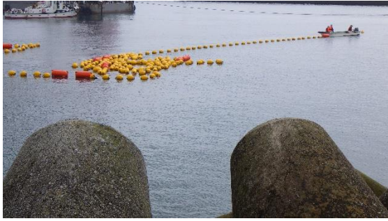
(写真 2 - 2) 魚類移動防止網の設置状況② (東波除提中央から撮影)
