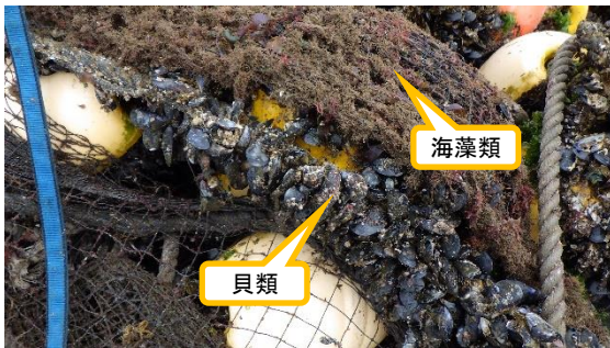
(写真 3 - 2) 回収された魚類移動防止網の状況② (物揚場中央部で撮影)
