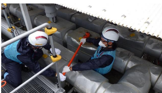
(写真2-3) グループ1の排水弁を開放
