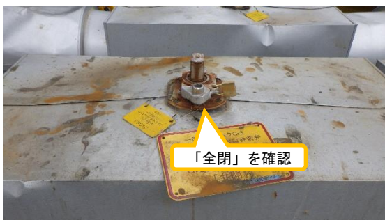
(写真2-2) 排水しないグループ3の排水弁 「全閉」であることを確認
