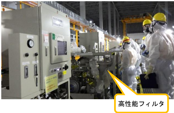
(写真3) 高性能フィルタ点検作業（準備作 業）の状況（西側から撮影）
