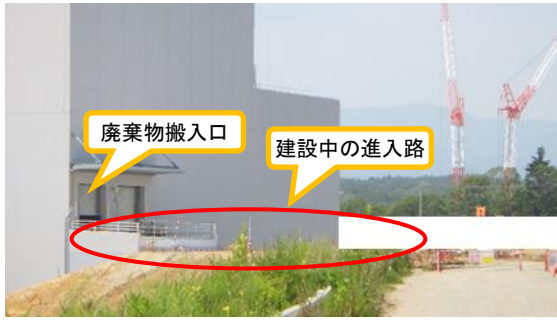
(写真 2-1) 廃棄物搬入口の進入路の状況 (令和 2 年 8 月 5 日撮影)
