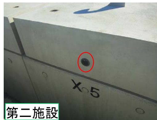
ボックスカルバートの換気口の例
